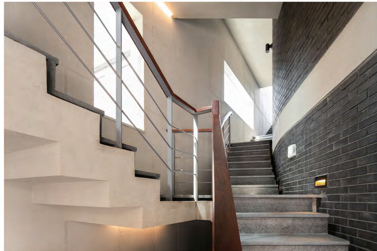
직선과 곡면벽 사이를 이동하는 깊이감 있는 계단은 노출콘크리트 벽체 쪽으로는 캔틸레버 구조, 벽돌벽 쪽으로는 슬라브 구조임을 단면 형상으로 드러내고 정갈한 마감을 위해 구체 위에 각파이프 틀을 설치한 후 돌을 붙이는 방식을 채택했다. As a structural phenomenon, the staircase with a depth that traverses a linear line to a curved wall displays its cantilever structure towards the exposed concrete wall and its slab structure towards the brick wall, and the placing of stones after installing a square pipe frame above the concrete was chosen for a clean finish.
