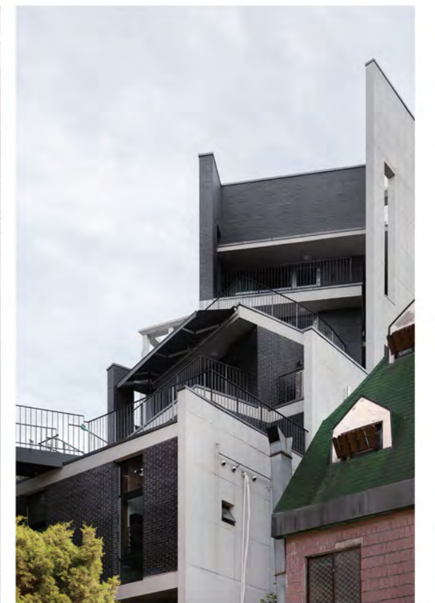
외부 공간을 최대한 확보할 목적으로 수직코어를 도로의 전면에 배치하고 곡선 형태의 각종 평면을 법적 제한선을 비껴가며 쌓아올린 결과, 각종의 테라스가 위치한 복층은 활기찬 외관을 형성한다. With this intention to secure maximum space, the vertical core was placed at the front of the road and the floor area was piled up in a curved form while staying close to the legal limits.
